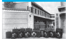
1932(昭和7年) 暖房用ユニットヒーター
