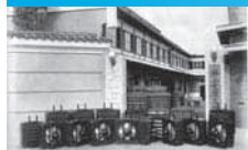
1932(昭和7)年 暖房用ユニットヒーター
